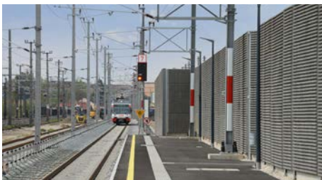
Beidseitig hoch absorbierende Beton-Lärmschutzelemente schlucken den Schall innerhalb und außerhalb der Gleise.
