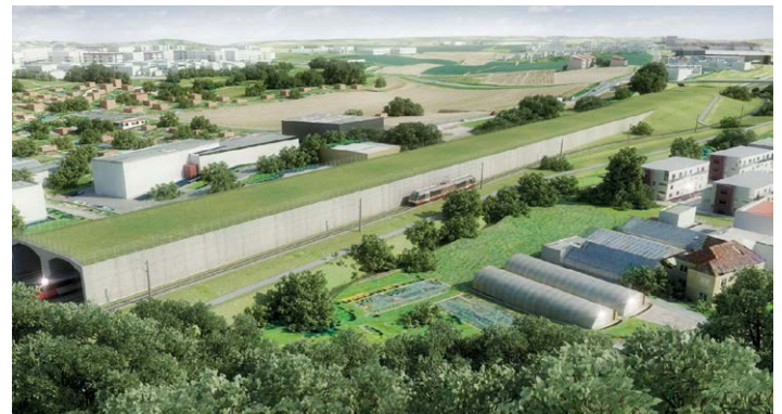
Visualisierung der ÖBB: So könnte eine Einhausung im Bereich der Gerstmayrstraße aussehen.
